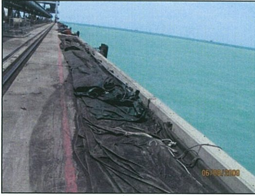
รูปที่ 7 ผ้าใบสำหรับป้องกันถ่านหินตกลงในทะเลขณะขนถ่ายถ่านหินขึ้นจากเรือ ควรมีการทำความสะอาดทุกครั้งก่อนที่จะใช้งานใหม่ เพื่อป้องกันเศษถ่านหินที่ตกค้างอยู่เดิมตกลงสู่ทะเลขณะทำการติดตั้ง
