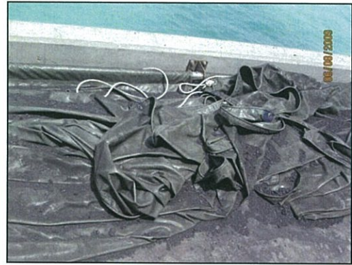
รูปที่ 7 ผ้าใบสำหรับป้องกันถ่านหินตกลงในทะเลขณะขนถ่ายถ่านหินขึ้นจากเรือ ควรมีการทำความสะอาดทุกครั้งก่อนที่จะใช้งานใหม่ เพื่อป้องกันเศษถ่านหินที่ตกค้างอยู่เดิมตกลงสู่ทะเลขณะทำการติดตั้ง
