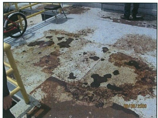
รูปที่ 6 พื้นที่สำหรับแลกบัตรบริเวณทางเข้าท่าเรือขนถ่ายถ่านหิน มีน้ำขัง และพื้นบางส่วนผุ ซึ่งอาจเกิดอันตรายต่อผู้ปฏิบัติงานในบริเวณดังกล่าว
