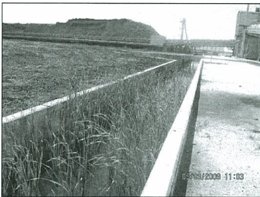
รูปที่ 2 ต้นธูปฤาษีที่ขึ้นอยู่ในรางระบายน้ำโดยรอบลานกองถ่านหิน และเศษถ่านหินที่สะสมอยู่ภายในรางระบายน้ำซึ่งควรทำความสะอาดให้เรียบร้อย
