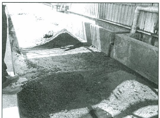
รูปที่ 2 ต้นธูปฤาษีที่ขึ้นอยู่ในรางระบายน้ำโดยรอบลานกองถ่านหิน และเศษถ่านหินที่สะสมอยู่ภายในรางระบายน้ำซึ่งควรทำความสะอาดให้เรียบร้อย
