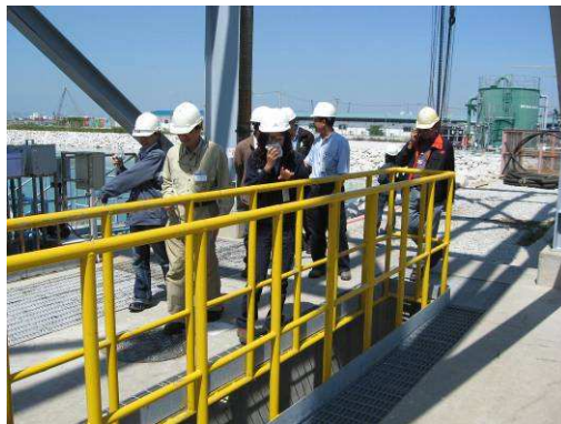
รูปที่ 1 ราวสีเหลืองที่ติดตั้งไว้เพิ่มเติมบริเวณคลองรับน้ำหล่อเย็น
