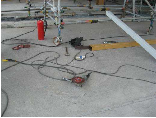
รูปที่ 3 การจัดเก็บอุปกรณ์ในการซ่อมบำรุงไม่เป็นระเบียบซึ่งอาจทำให้เกิดอันตรายต่อคนงาน ในบริเวณดังกล่าวได้
