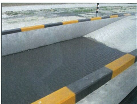
รูปที่ 3 Wheel Washing ที่ติดตั้งอยู่บริเวณลานกองถ่านเพื่อรอกการขนส่งไปกำจัด
